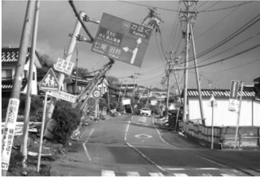
道路の損壊と寸断で救援が遅れている (石川県内灘町)
