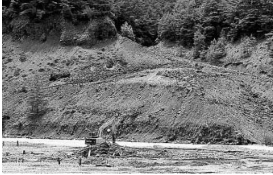
リニア工事による残土処理の問題が焦点化している
